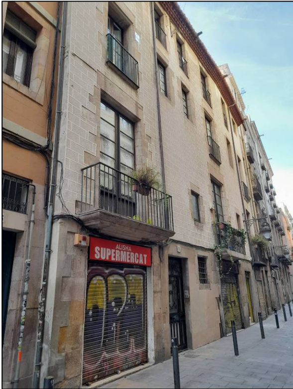
Foto 1. Exterior de l'edifici.
