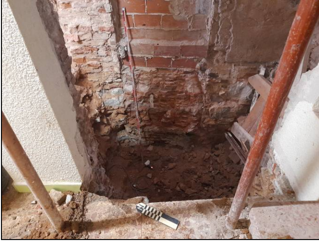
Foto 9. Vista del fossat de l'ascensor un cop finalitzat.
