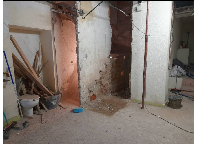
Foto 6. Ubicació del nou ascensor.
