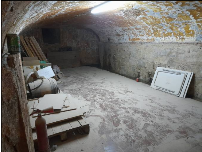
Foto 5. Vista del soterrani.
