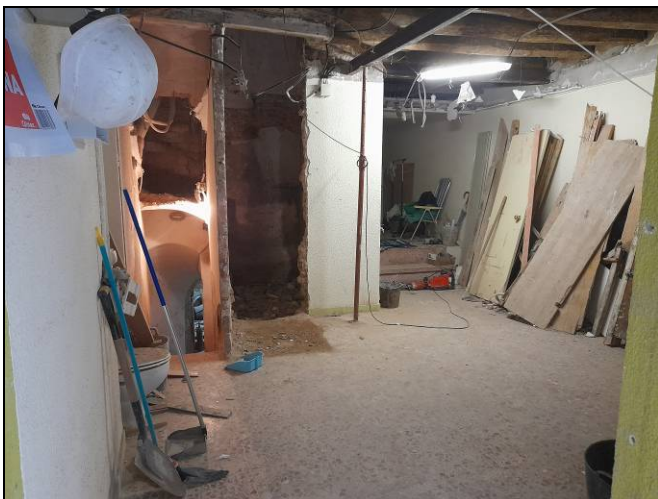
Foto 3. Interior de la planta baixa a l'inici de la intervenció.
